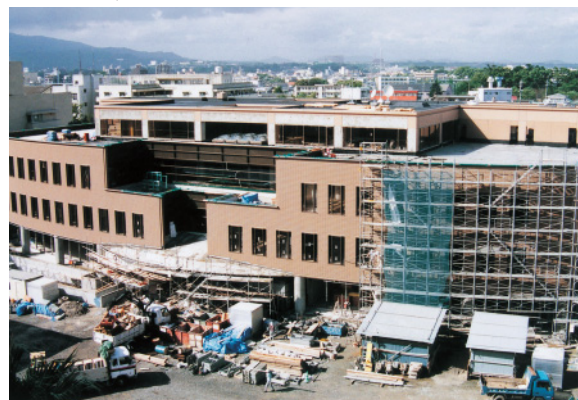
新築工事が進む図書館(平成6年)
