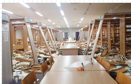
多くの書架が破損
